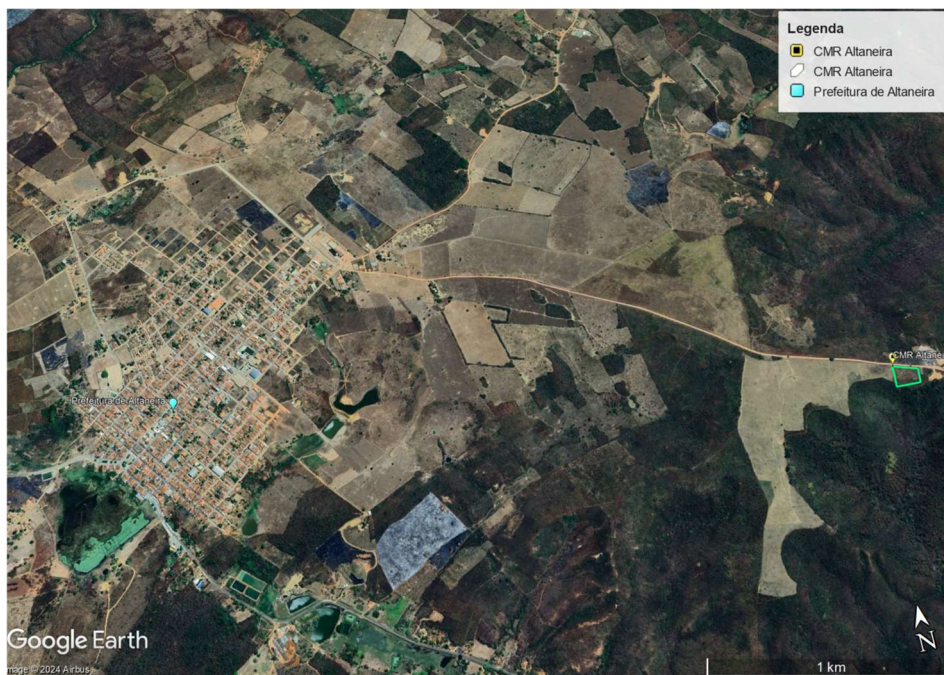
Figura 3 - Localização da CMR de Altaneira e sua proximidade com infraestruturas viárias.
